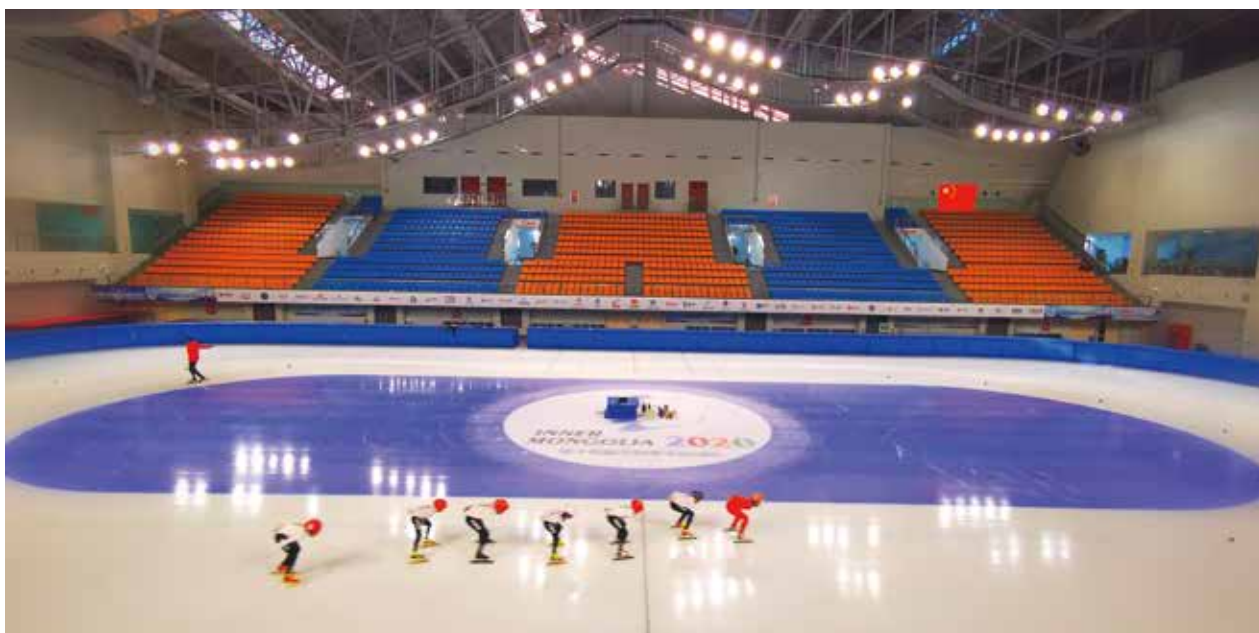
“十四冬”主场馆——内蒙古冰上运动训练中心
