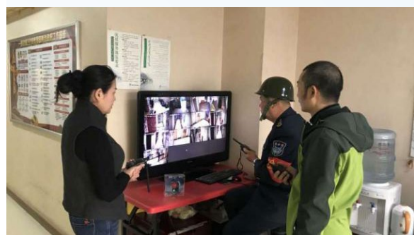
安装监控系统
