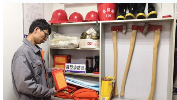
检测微型消防站
